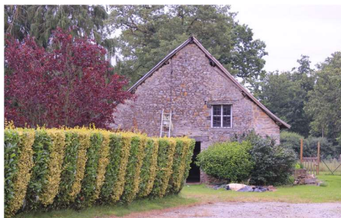
Vues du bâtiment
