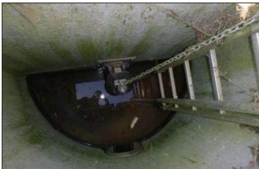
Figure 44 : Photo d'un exemple d'une vanne à chaînette dans un ouvrage de sortie de bassin d'orage
